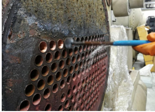
Şekil 8. Yoğun kirlenmiş bir ısı eşanjörünün tüp temizliği
